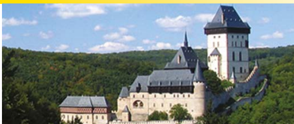
Řízení úpravy vzduchu – hrad Karlštejn Česká republika
